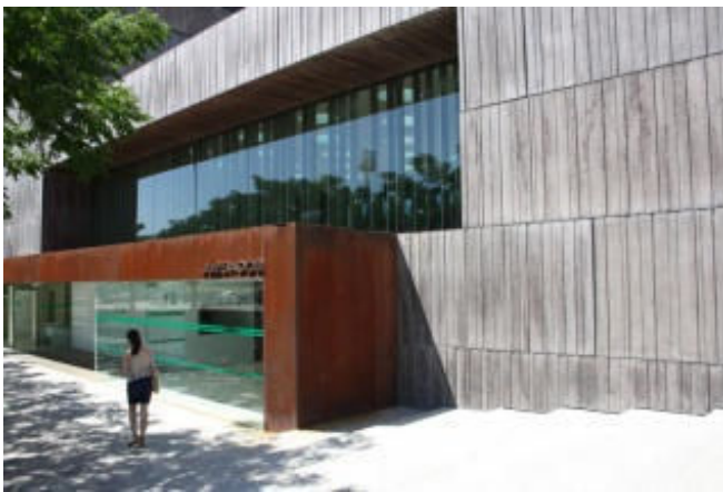
Fachada de los Juzgados de Antequera.
