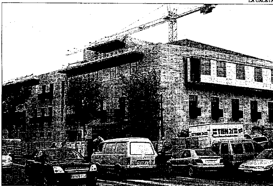
El Palacio de Justicia de Toledo prevé abrir sus puertas durante el primer trimestre del año que acaba de comenzar. En la imagen, el edificio en obras.
