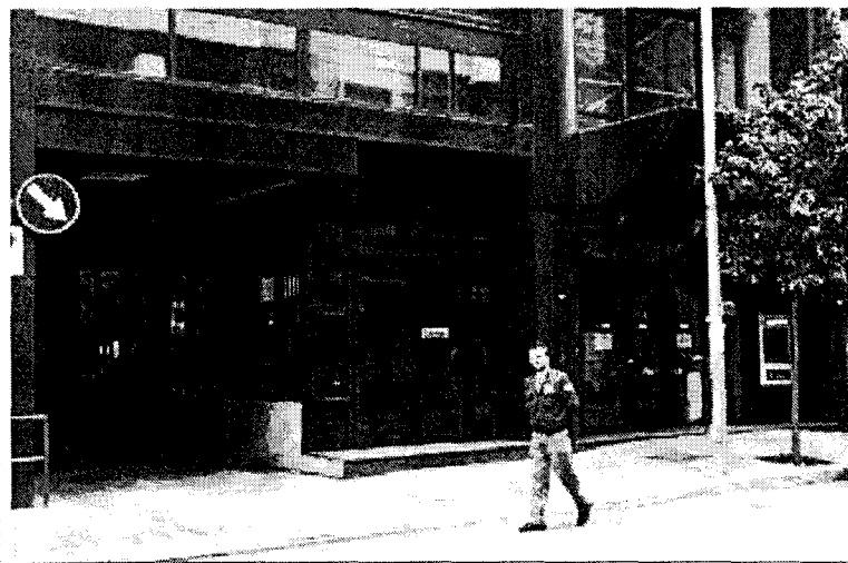
El edificio Viapol, donde se ubican los juzgados de Primera Instancia, en una imagen de archivo.
