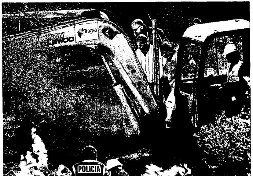
Una excavadora abre una zanja en el paraje de Caño Ronco, en Camas (Sevilla), ayer. EFE
