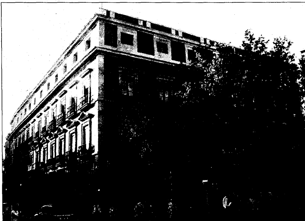
Sede del Registro Civil Central, ubicado en la plaza de Benavente, en Madrid.
