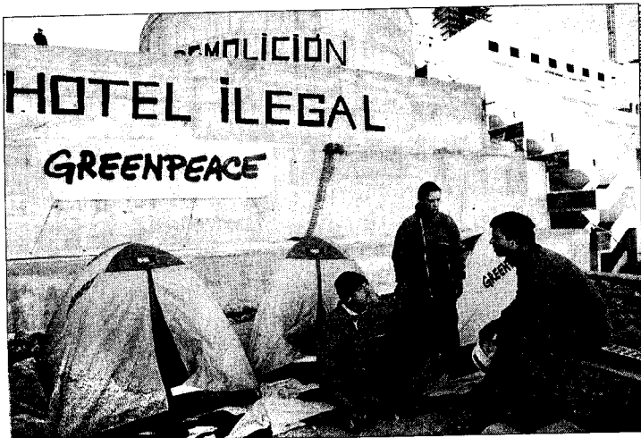
VARIOS ACTIVISTAS de Greenpeace acamparon el pasado 16 de noviembre junto al hotel que se está construyendo de manera ilegal en la playa del Algarrobico en Cabo de Gata (Almería).
