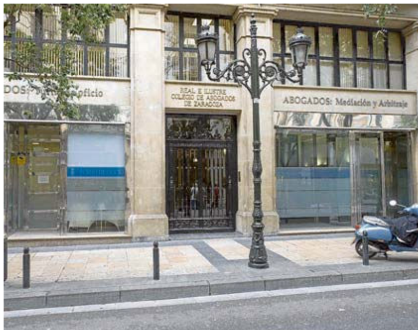
Servicios. Instalaciones del Colegio de Abogados de Zaragoza con sus distintas dependencias.
