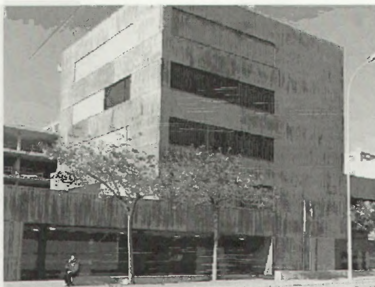
Vista de los modernos Juzgados de Antequera :: ANTONIO FUENTES
