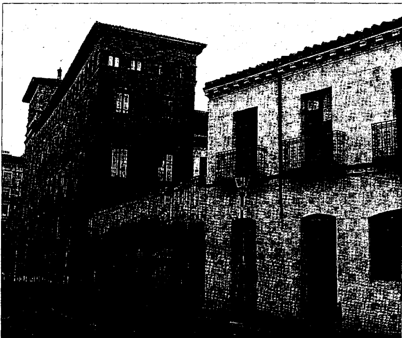
►► La ampliación del Palacio de Justicia se llevará a cabo en la parte trasera del edificio.
