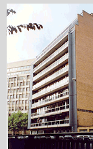
Edificio sede de la Delegación del CGAE y nueva sede del CCBE
