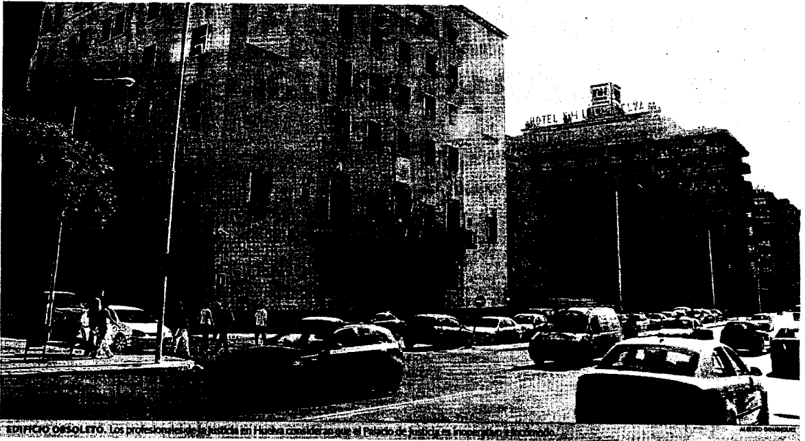
EDIFICIO OBSOLETO. Los profesionales de la justicia en Huelva consideran que el Palacio de Justicia merece una reforma.
