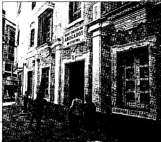
►► Fachada de la sede del Colegio de Abogados.
