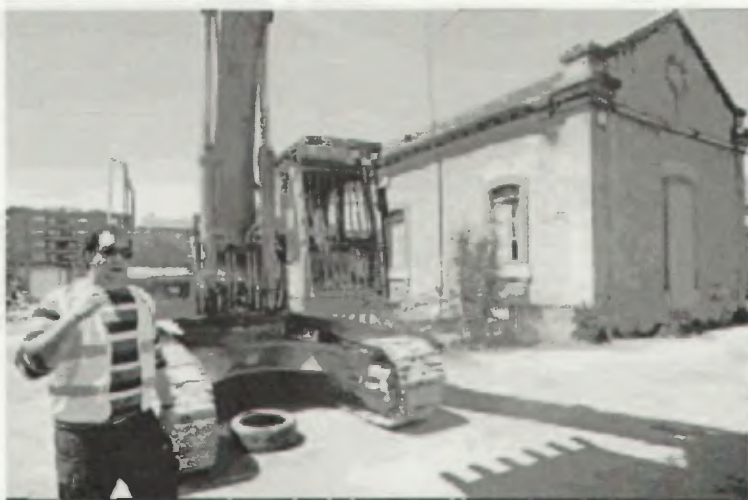
Las grúas, ayer tarde, reanudarán para demoler la estructura del antiguo hospital militar. © JUAN MARÍN
