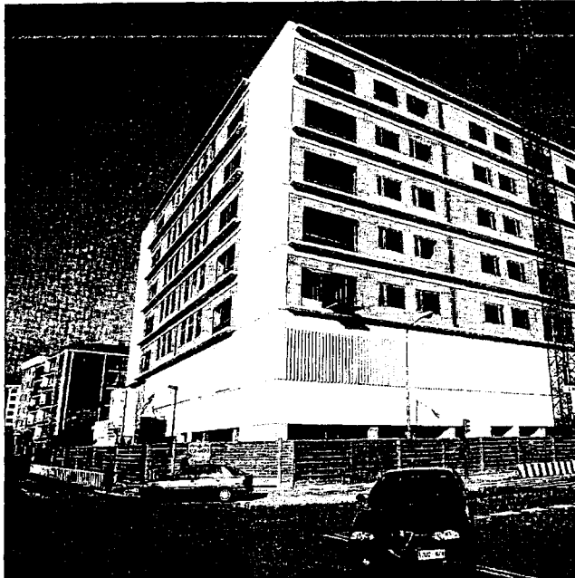
En el nuevo edificio existe espacio para albergar nuevas instancias judiciales. / LUIS LÓPEZ ARAICO
