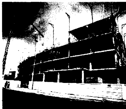
Estado de las obras en octubre del pasado año. /P.U.
